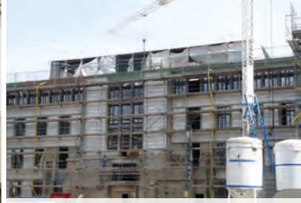
Campus Johannstadt in der Umbauphase
